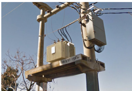
Figura 1. Un transformador de distribución de 250 kVA según IRAM 2250.
